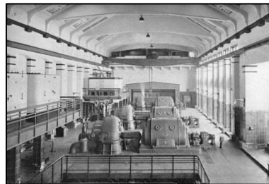
Machinehal rond 1932. Totaal vermogen 95.000 kW.
