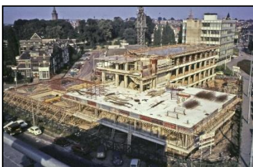
Foto: Bouw voormalig Belastingkantoor, een project van Theo.
